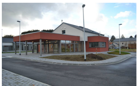
Construction de 22 logements en résidences-services à Hotton
